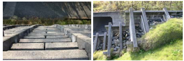
写真 6 道の駅ちぢみの里おじやの枠組擁壁
