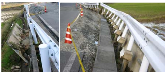
写真 5 小千谷市若葉団地内の道路擁壁
