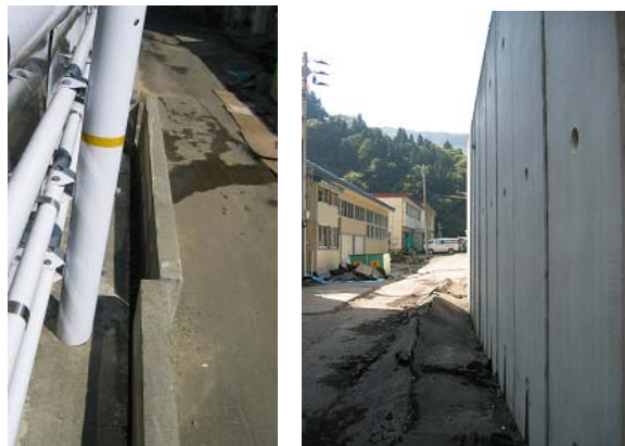
写真 8 長岡市蓬平町のL型擁壁
