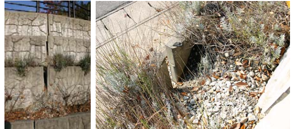
写真 7 道の駅ちぢみの里おじやの箱型擁壁
