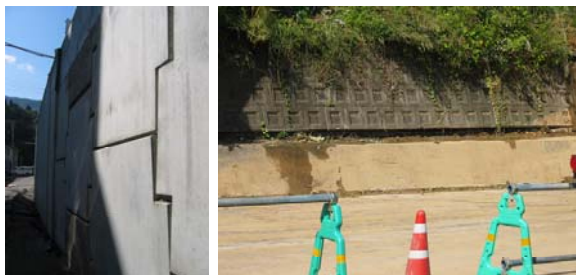
写真 9 長岡市蓬平町県道 515 号の補強土壁，切土部擁壁
