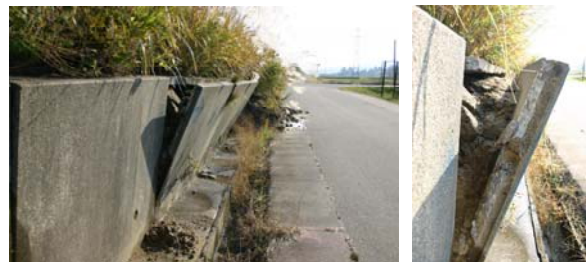
写真1 関越自動車道のL型擁壁(小千谷IC付近)
