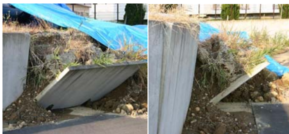
写真 4 小千谷市若葉団地内の宅地擁壁
