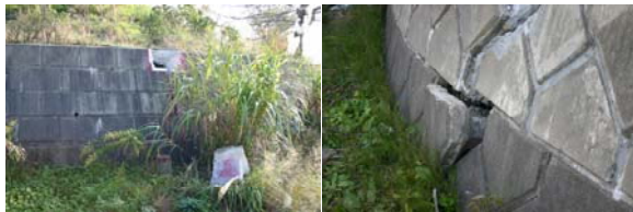
写真 3 関越自動車道のブロック積み擁壁
