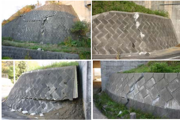
写真 2 関越自動車道のブロック積み擁壁
