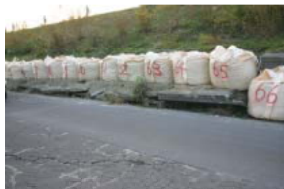
写真2 関越自動車道の土羽止め擁壁
