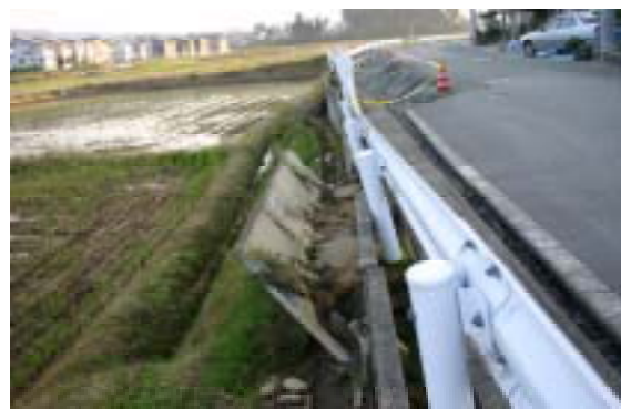
写真3 小千谷市若葉団地内の道路擁壁
