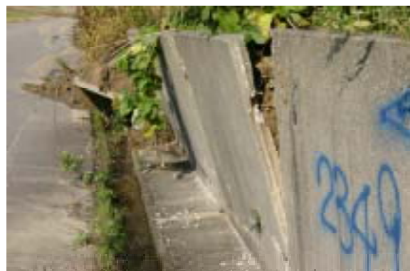
写真1 関越自動車道の土羽止め擁壁
