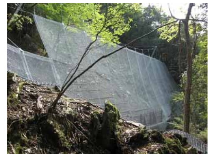
(e) 安倉林地荒廃防止工事(北川村)
