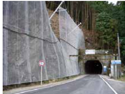
(d) 国道 319 号防災工事(四国中央市)
