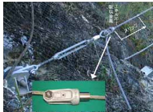
写真1 エネルギー吸収金具
