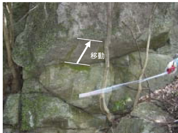
写真4 芸予地震による岩塊の抜け出し
