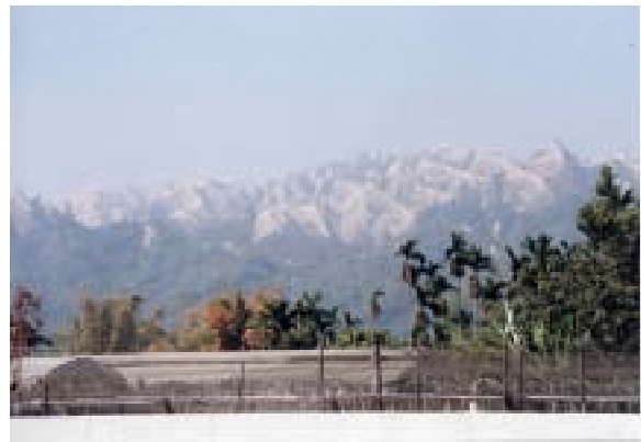
写真2 南投県火炎山の表層崩壊(台湾地震)
