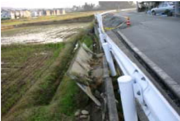
(a)道路擁壁
