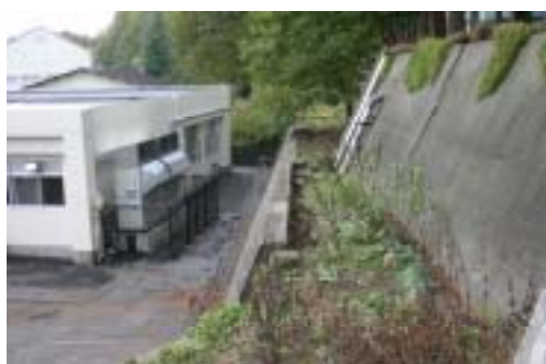
写真 - 8 長岡市高町の切土部のブロック積み擁壁
