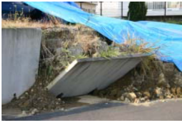
(b)宅地擁壁
