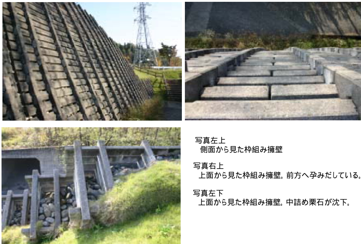
写真 - 11 国道 17 号道の駅ちぢみの里おじやの枠組み擁壁
