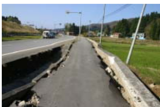
写真 - 7 国道 117 号越後川口 IC 付近のブロック積み擁壁
