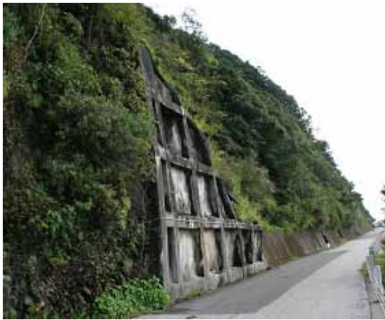
コンクリート法枠工法
