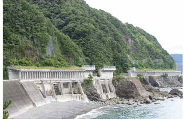
ありとあらゆる落石対策工が施工されている高知県道 320 号久礼須崎線は落石対策の見本市。
