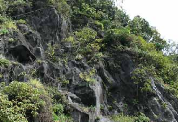
特殊金網を法面に密着して張り，浮石をpushさえ込み落石を防止するマイティーネット。ネット内には自然の種子が付き，緑化されている。
