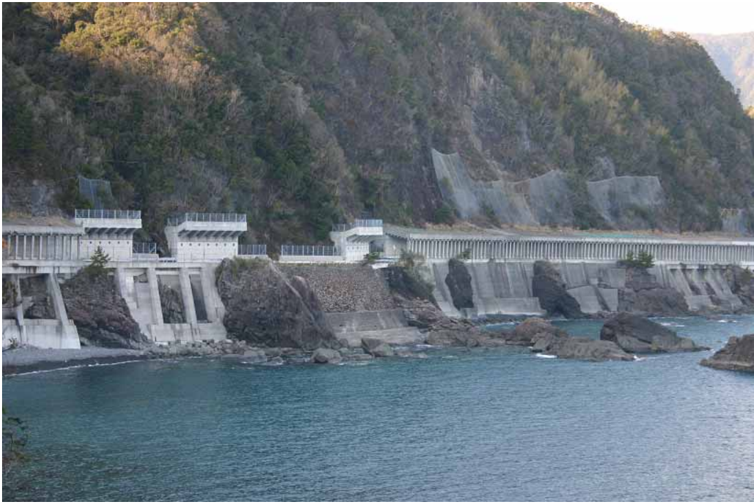
高知県道 320 号に施工されている落石対策工
