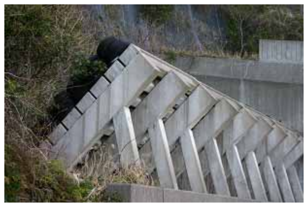
バリヤーと呼ばれるプレキャストコンクリート製の待ち受け式落石防護柵。
