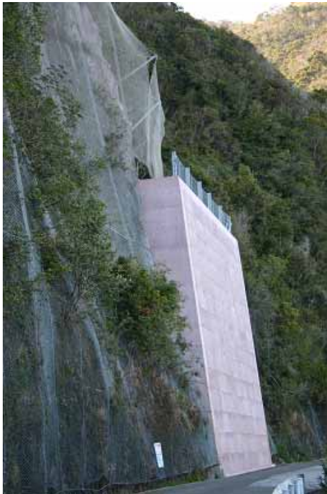
S.P.C.ウォール工法。壁面にプレキャスト化粧板を使用し，地山との間には気泡混合軽量盛土材であるエアームタルが施工されている。
