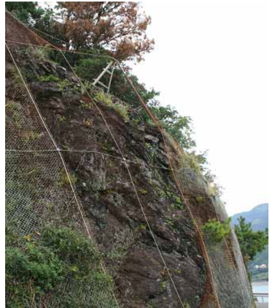
高知県の土木技師・田中忠夫氏が考案したポケット式ロックネット。金網は腐蝕してなくなった所もある。
